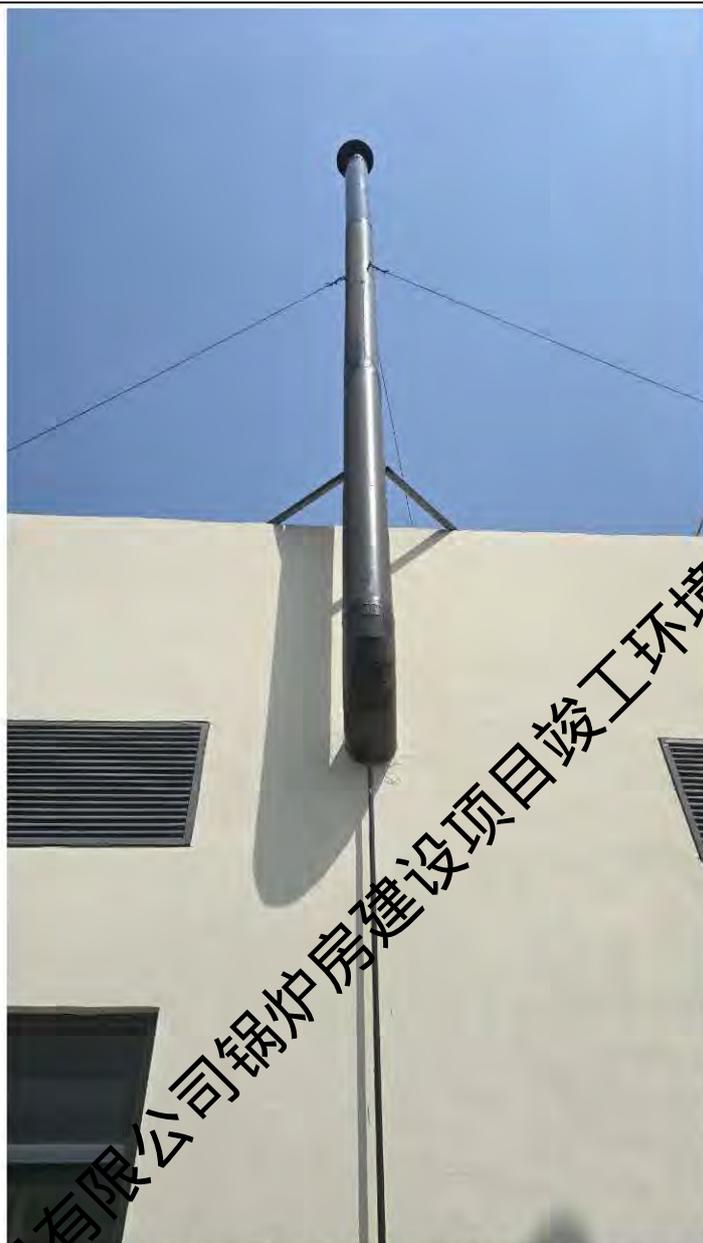
图 3-4 本项目 15m 高锅炉废气排气筒
