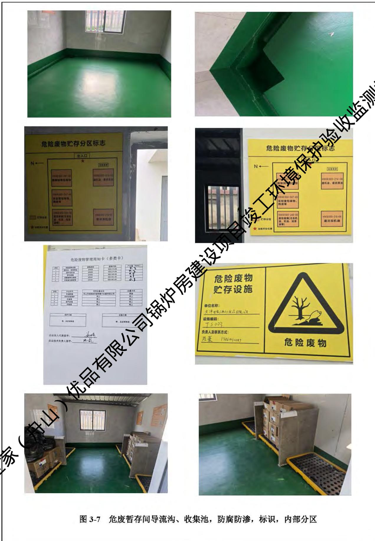
图 3-7 危废暂存间导流沟、收集池，防腐防渗，标识，内部分区
