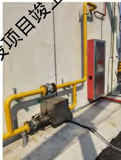
图 3-8 本项目锅炉房柜式气体灭火装置、消防栓
