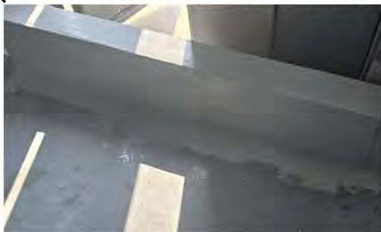
图 3-9 本项目锅炉房导热油储槽围堰
