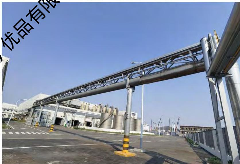
图 3-3 本项目管路走向（导热油、压缩空气、氮气）
