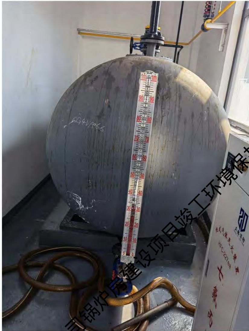
图 3-2 本项目 4m<sup>3</sup> 储油槽
