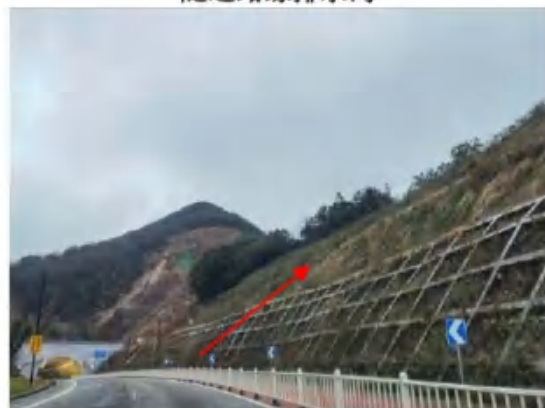
隧道口边坡绿化
