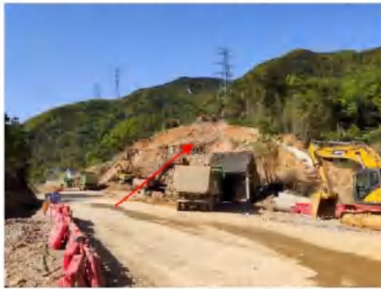
路基表土剥离
