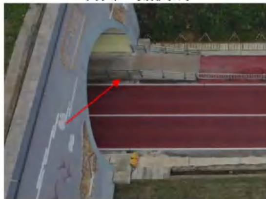
隧道路缘排水沟
