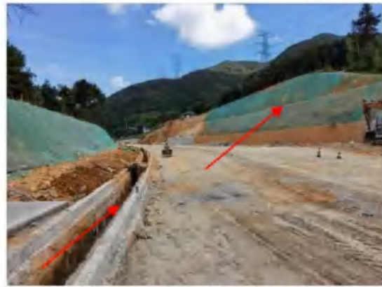
临时排水、沉沙、临时防尘网覆盖
