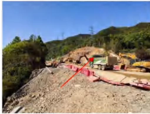
路基表土剥离
