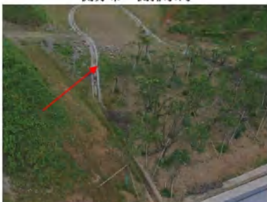
隧道洞口截排水工程
