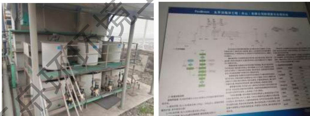
图 8.2.1-2 废水处理装置和工艺流程图
