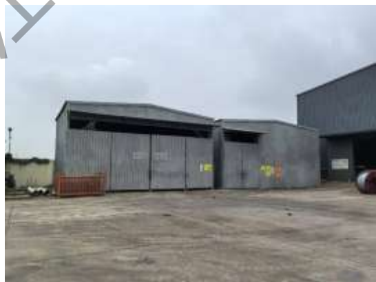
废油泥包堆场
