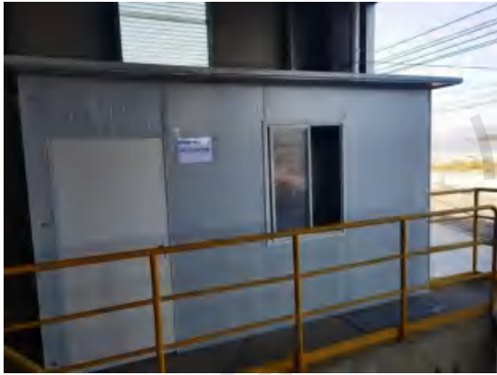
综合废水监测站房
