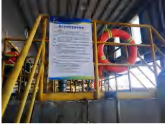
污水处理站操作规程
