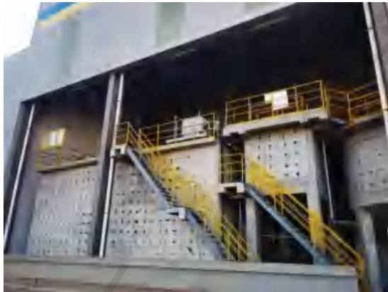
污水处理站外部（局部）
