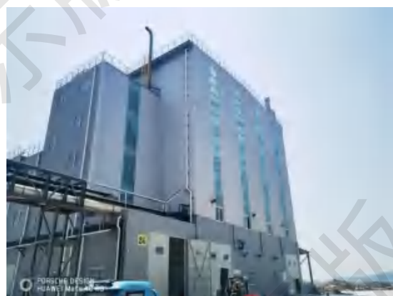
酸再生粉尘废气排放口
