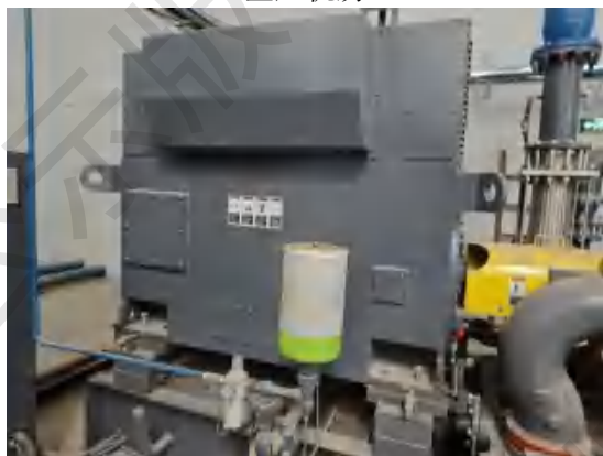
基础固定+隔声罩
