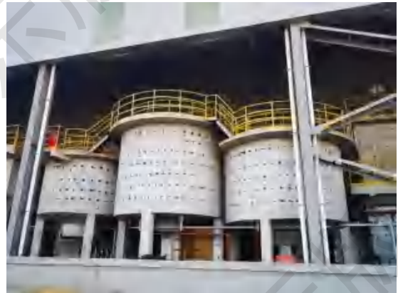
污水处理站外部（局部）
