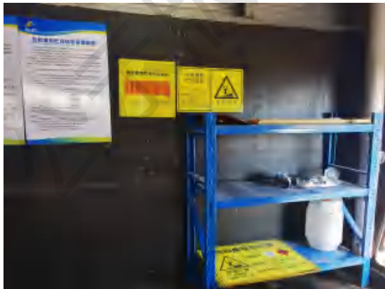
危废仓库内部
