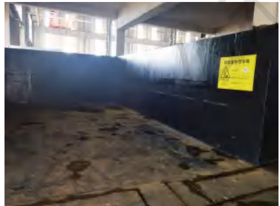
危废仓库内部
