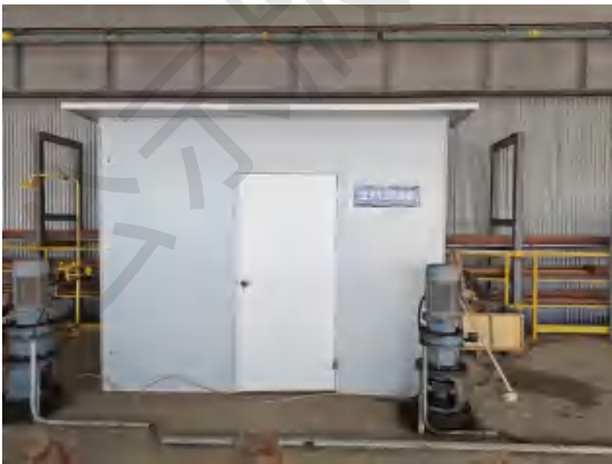
车间排放口监测站房
