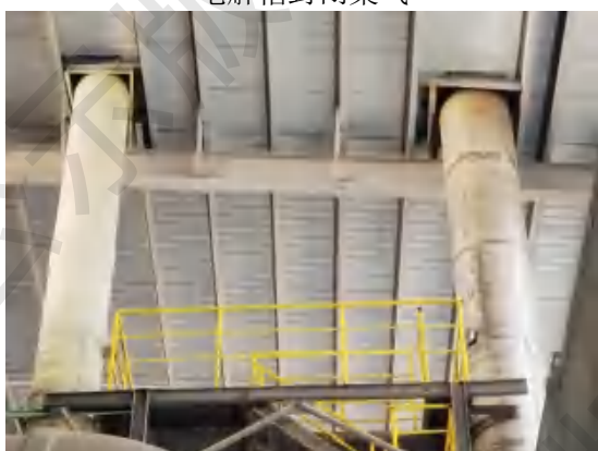
电解和酸洗废气采样口
