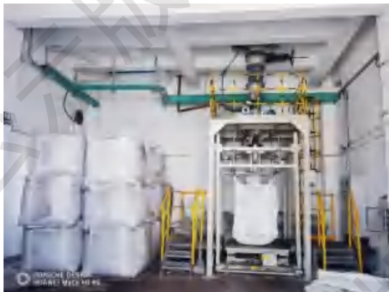
一般固废暂存场所
