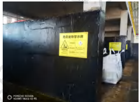
危废仓库内部
