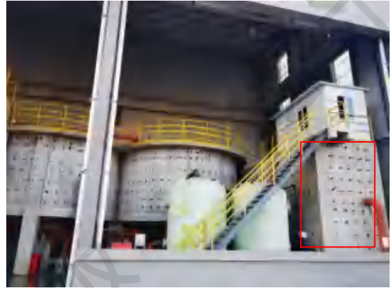
污水处理站回用水池
