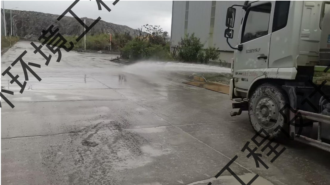
图 6.1-1 运输道路洒水
